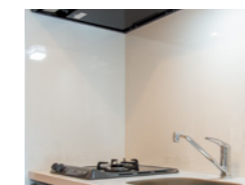
キッチンパネル 汚れが落としやすいメラミン化粧板を採用しております。
