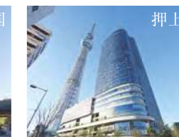
押上 東武鉄道(株)本社
