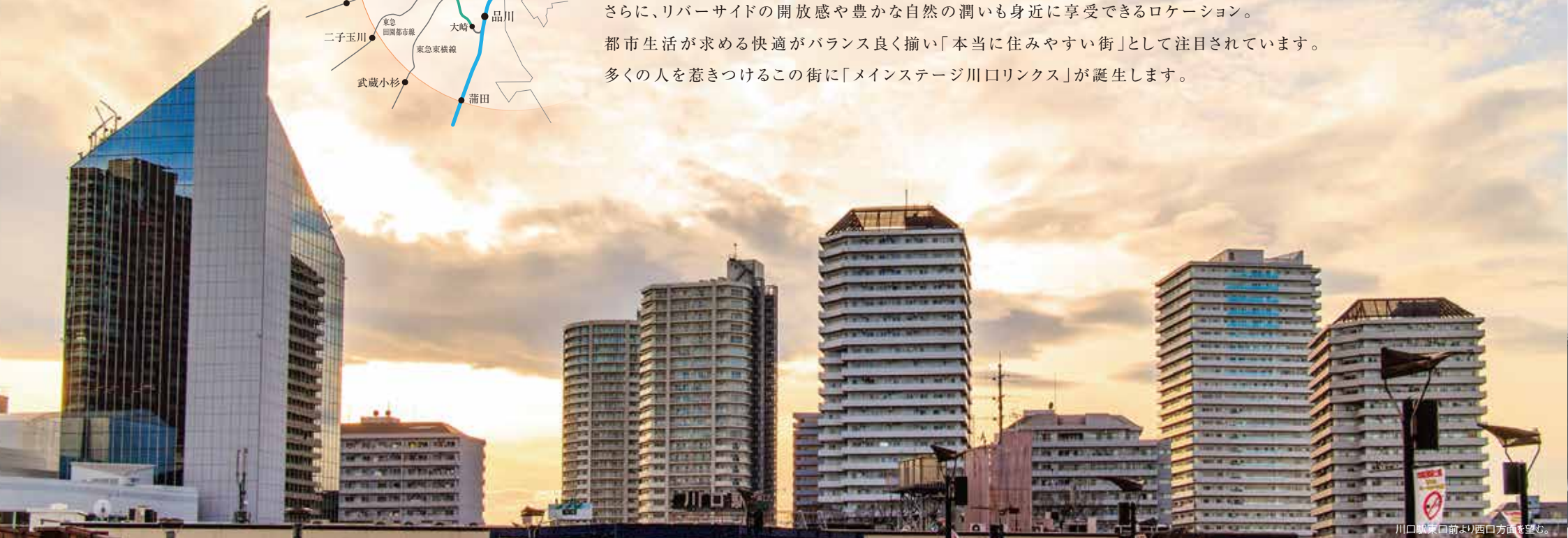
川口駅東口前より西口方面を望む。
